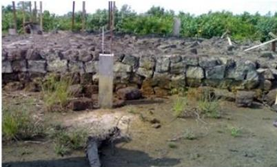
5. Mise en place d'une fondation pour une construction définitive dans une zone de mangrove de Douala
