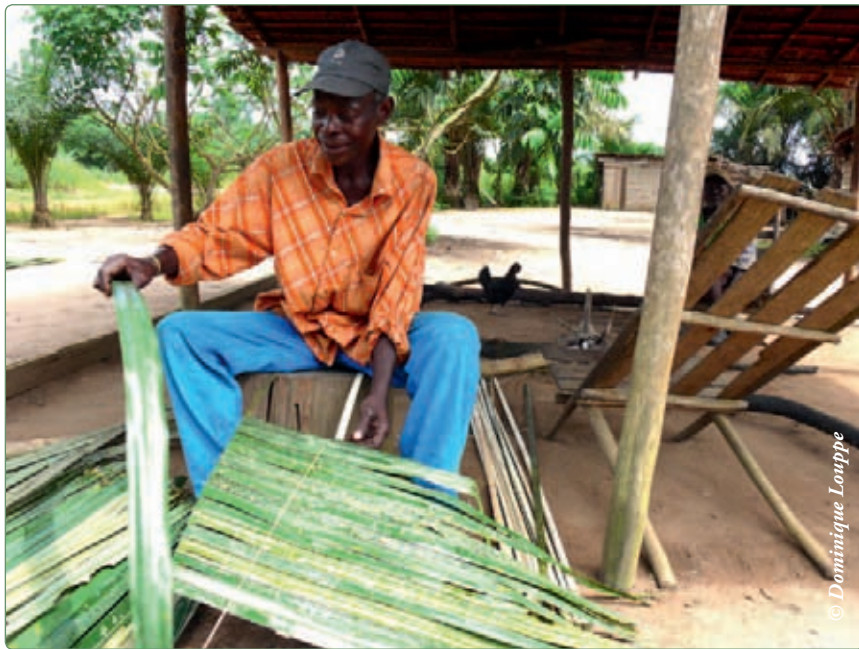
Photo 10.13: Construction d'une toiture en feuilles de palmiers – Congo
