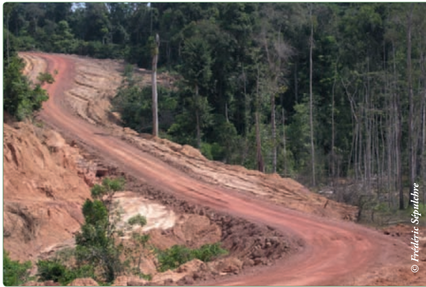
Photo 10.8: Signes d'érosion et d'obstruction de fond de vallée suite à la construction d'une route forestière – Gabon
