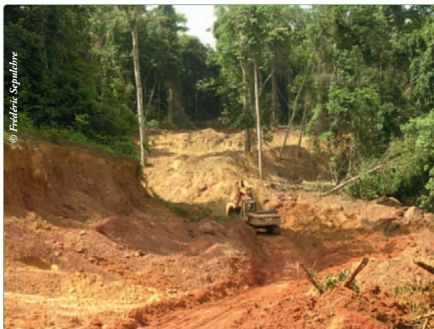
Photo 9.12: Carrière de latérite en activité – Gabon
